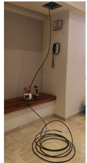
Instalación de Cableado Interior
